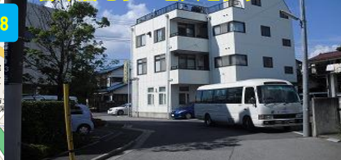
⑮東京湾岸リハビリテーション病院 谷津居宅サービスセンター
